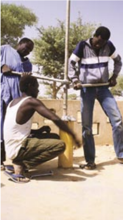
Techniques de forage manuelles à bas coûts
